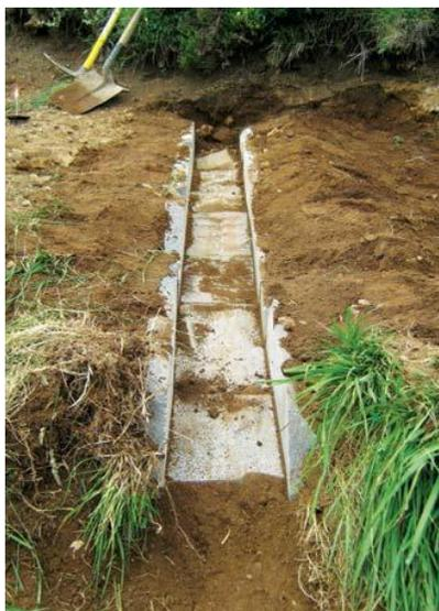
Exemple de dispositif de renvoi d'eau (source\* : Techniques d'aménagements des cheminements sur sols volcaniques fragiles. Gguide de l'écochantier. PNR Volcans d'Auvergne).
